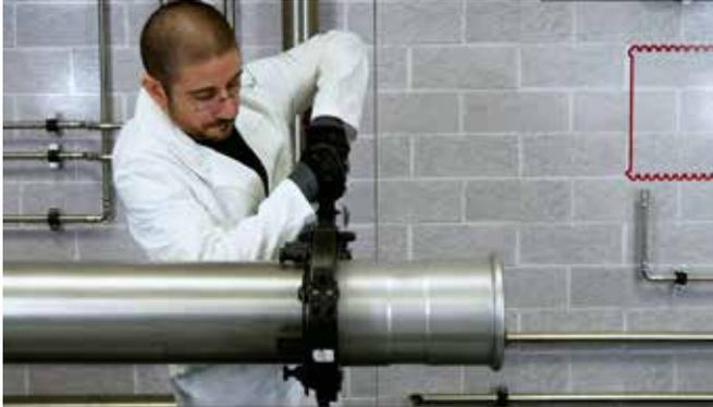
**Bild 18** – Herstellen der Pressverbindung n°1**2° DRUCKPHASE**
