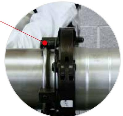
Nach dem Verpressen ist die hergestellte Verbindung auf korrekte Ausführung und Einhaltung der Einstecktiefe zu prüfen.
