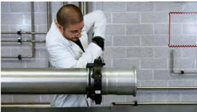
**Bild 19** – Herstellen der Pressverbindung n°2
